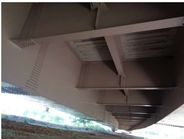
교량 바닥판 전경
