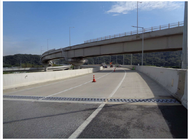
교량 상부 전경
