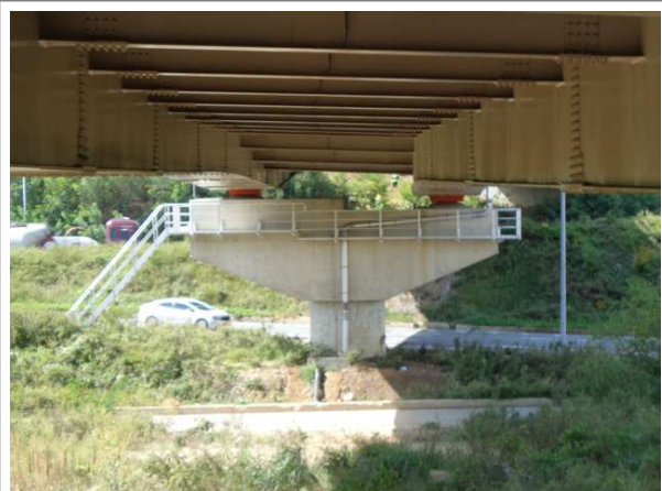
교량 하부 전경
