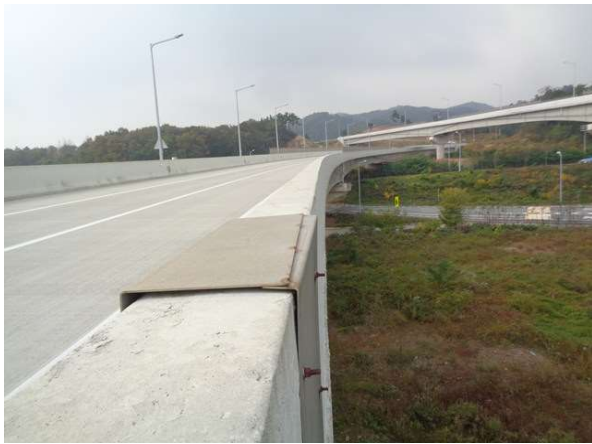
교량 측면 전경
