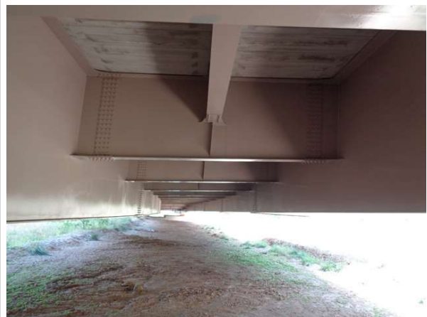
교량 거더 전경
