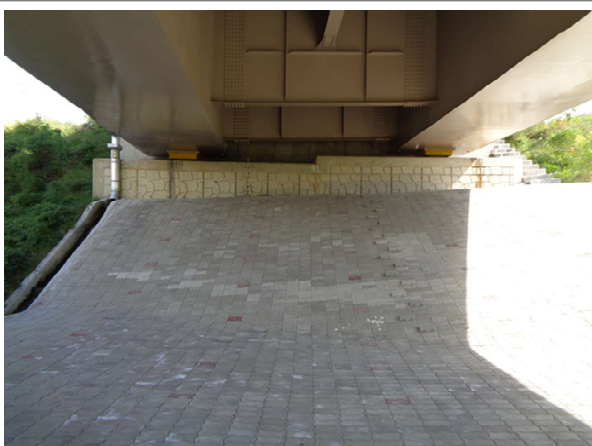
교량 하부 전경
